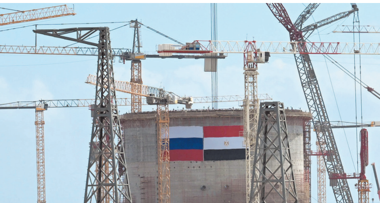
تركيب وعاء ضغط المفاعل للوحدة النووية الثانية بمحطة الضبعة
