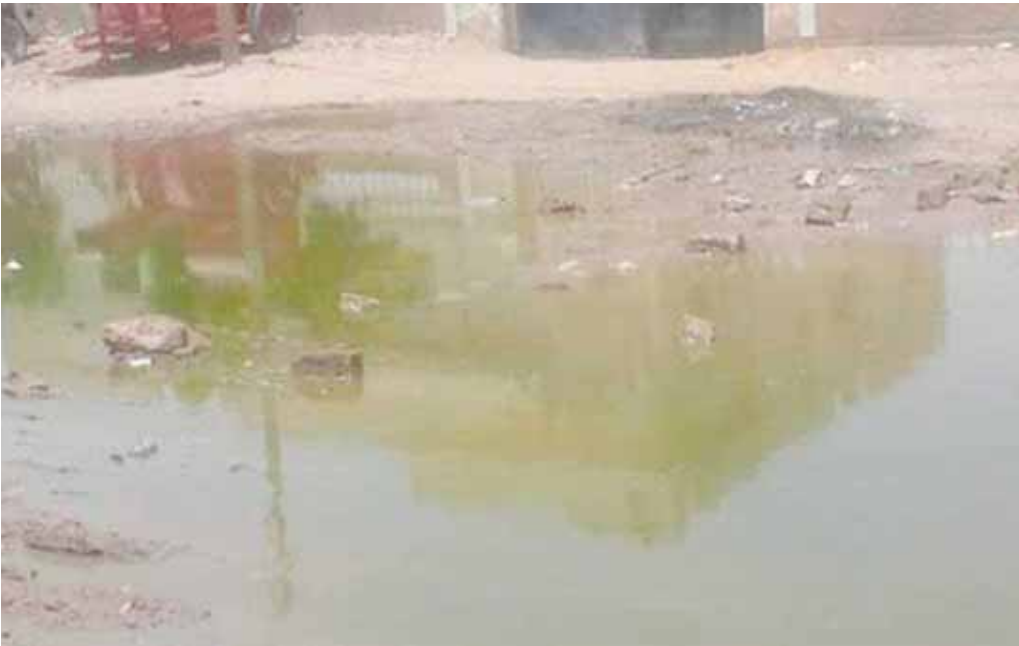
مياه راكدة نتيجة تهالك شبكتى مياه الشرب والصرف الصحى
