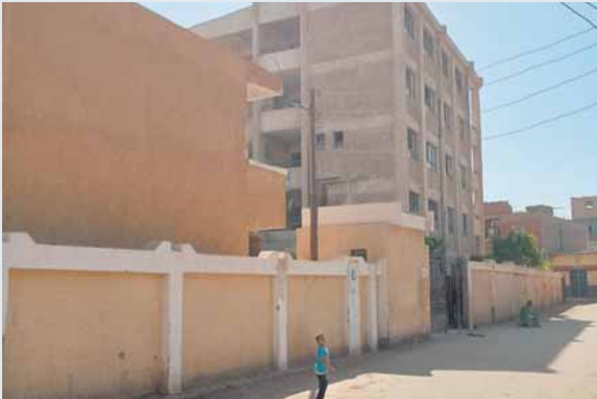
مدرسة نجع عايد بقنا تنتظر تنفيذ قرار الإزالة وإعادة البناء
